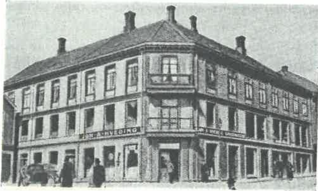
Et større firmas forret- ningsgård før brannen.
