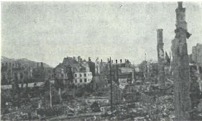
De ødelagte bygninger med Torvet i bakgrunnen
