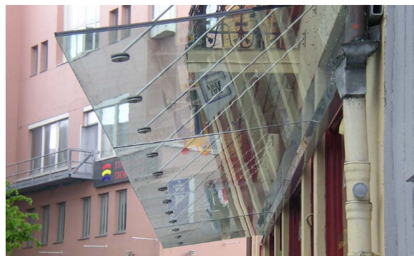
Baldakin i glass. Kilde: fanaglass.no
