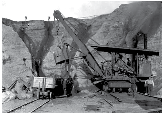
Her er dampgravemaskina Saturn i ferd med å grave seg gjennom jernbaneskjæringa i Våttabakken. Foto: Fotograf Aune gjennom Foreningen Gamle Steinkjer
