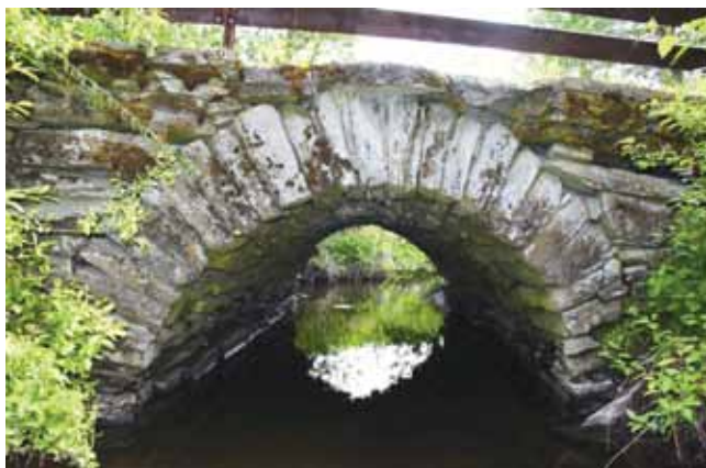
Kvelvbrua over Lundelva. Foto: Harald Duklæt
