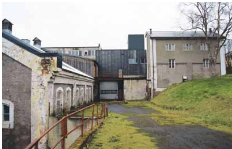
Øverst: Helge-Rein-By Brug; Søttemur og fundament for taubanen.
