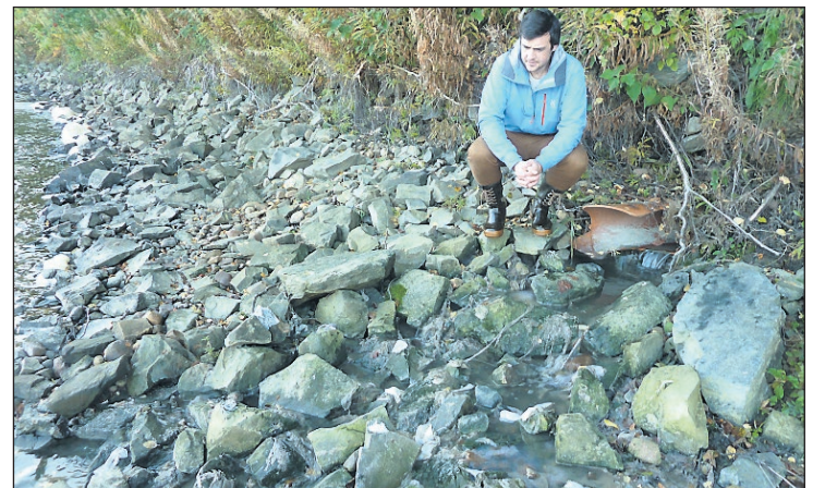
NYTT KLOAKKUTSLIPP: Marinbiolog Andreas Wæhre hos Fylkesmannen oppdaget denne uka et kloakkutslipp like ved Guldbergaunet.
