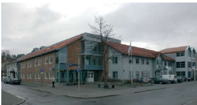
Mentalitetsendring i Steinkjer. Til høgre på bildet ser vi Gjensidigegården fra 1990-talet, den framspringande bygningskroppen heilt til høgre er bygd utan tanke på tilpassing til gjenreisingsarkitekturen. I 2003 er dette annleis. Nybygget til venstre på bildet er fint tilpassa med omsyn til takform, takvinkel, gesimshøgde og vindusutforming.
