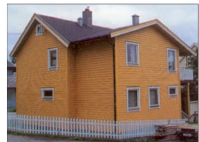
Noen ganger blir arealbehovet så stort at det opprinnelige bygget forsvinner bak alle tilbyggene. Foto: Edin Kippersrud
