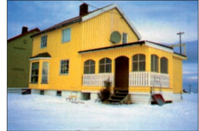
Mange gjenreisingshus har fått karnapp og tilbygg som i seg selv er fine, men endringene bidrar i liten grad til å framheve det opprinnelige bygget. Foto: Olaug Thortveit
