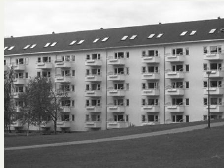
Ved å samle vinduene to og to over underliggende vinduspartier, oppnås en videreføring av eksisterende uttrykk og et roligere helhetsinntrykk. (Manipulert med ”riktig plassering” av vinduer)
