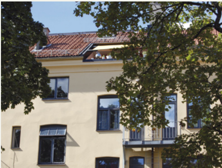
Når takterrassen bryter gesims, lages et "sår" som bryter den overordnede helheten i fasaden.
