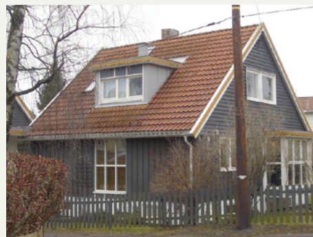
Nytt takoppbygg som på en god måte gir mer lys og ekstra areal til eksisterende loftsetasje, men hvor arkens takflate burde hatt et mer skrånende fall for å integrere den mer i taket som helhet.
