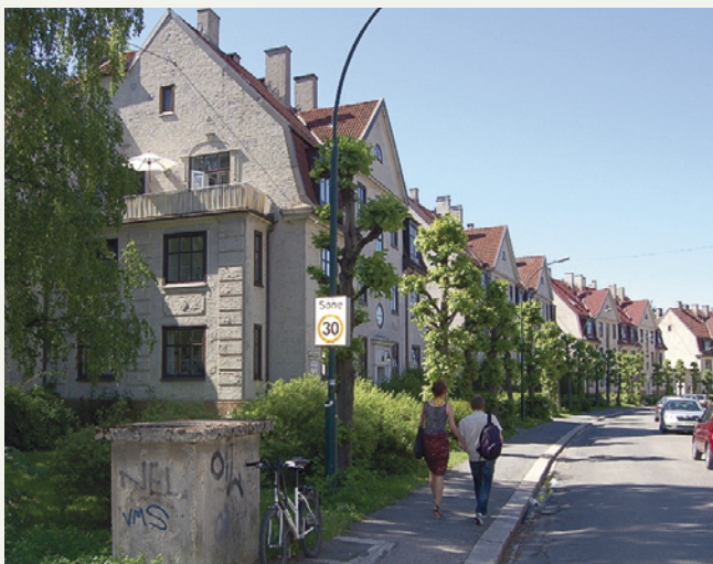
Eksempel på nybarokk bebyggelse: Lindern. Takene, med kraftige arker og gavlmotiver, spiller en viktig rolle i bybildet.
