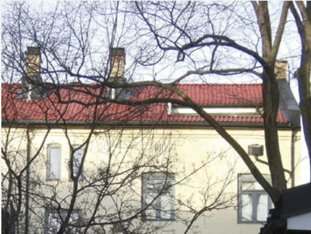
Takterrasse mot bakgård, godt inntrukket fra gesims og med avstand til branngravl.
