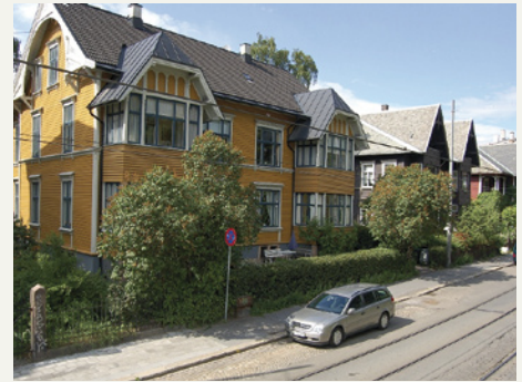
Byvillaer med intakte tak. De bratte ”uthengstakene” i den sene sveitserstilen er sårbare for inngrep.
