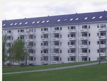
Godt dimensjonerte vinduer i takflaten. Men lengden på taket, mengden av vinduer og den uklare ordningen av dem, skaper i sum et for dominerende og uryddig uttrykk.
