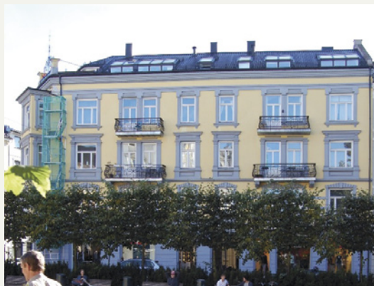
Mindre ryddig takflate som forstyrrer både fasadens rytme og plassrommet.
