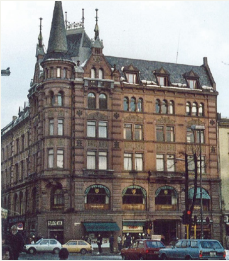
Hjørnebygning med rikt utvalg av velplasserte tårn, gavler og arker. Fordi taket er så bratt, bryter ikke arkene husets silhuett.
