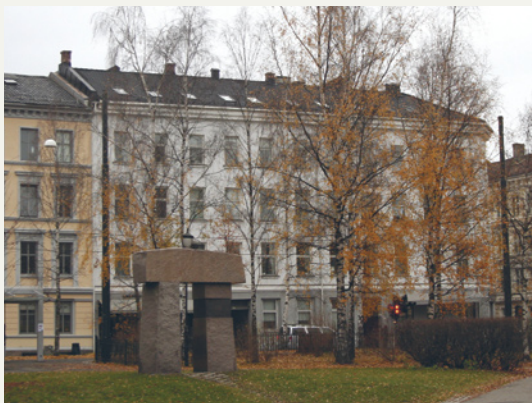
Forsiktig endret takflate bidrar til rolig innfatning av plassrom.
