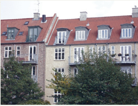
Velplasserte arker mot bakgård, delvis med "franske balkonger" som ikke bryter gesimsen. Eksempel fra København.
