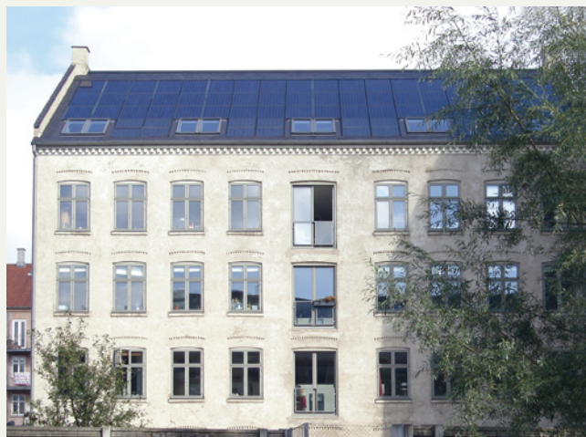
Godt integrert solfangersystem. Eksempel fra Danmark.
