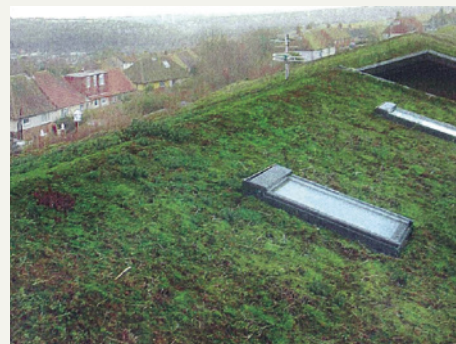
Grønt tak, som gir en generell økologisk gevinst, og som her spesielt ivaretar lokal behandling av overflatevann. Eksempel fra England.
