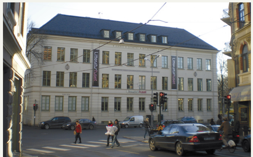
Det høye taket egner seg for arker. Arkene står tett, men de er små og følger vindusrytmen under, og utgjør ikke mer enn 1/3 av takets lengde.
