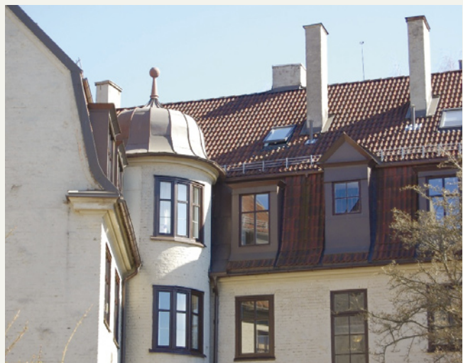
Eksempel fra nybarokk arkitektur: Mengden og plasseringen av opprinnelige elementer gir lite rom for flere inngrep i taket.
